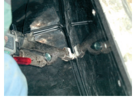
Bild 5: Vor Ort werden die Kunststoffplatten im Extrusionsschweißverfahren zu Wannen verschweißt
