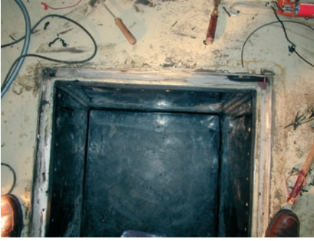
Bild 3: Kunststoffwanne eingelassen in die zu sanierende Grube, zweite Barriere
